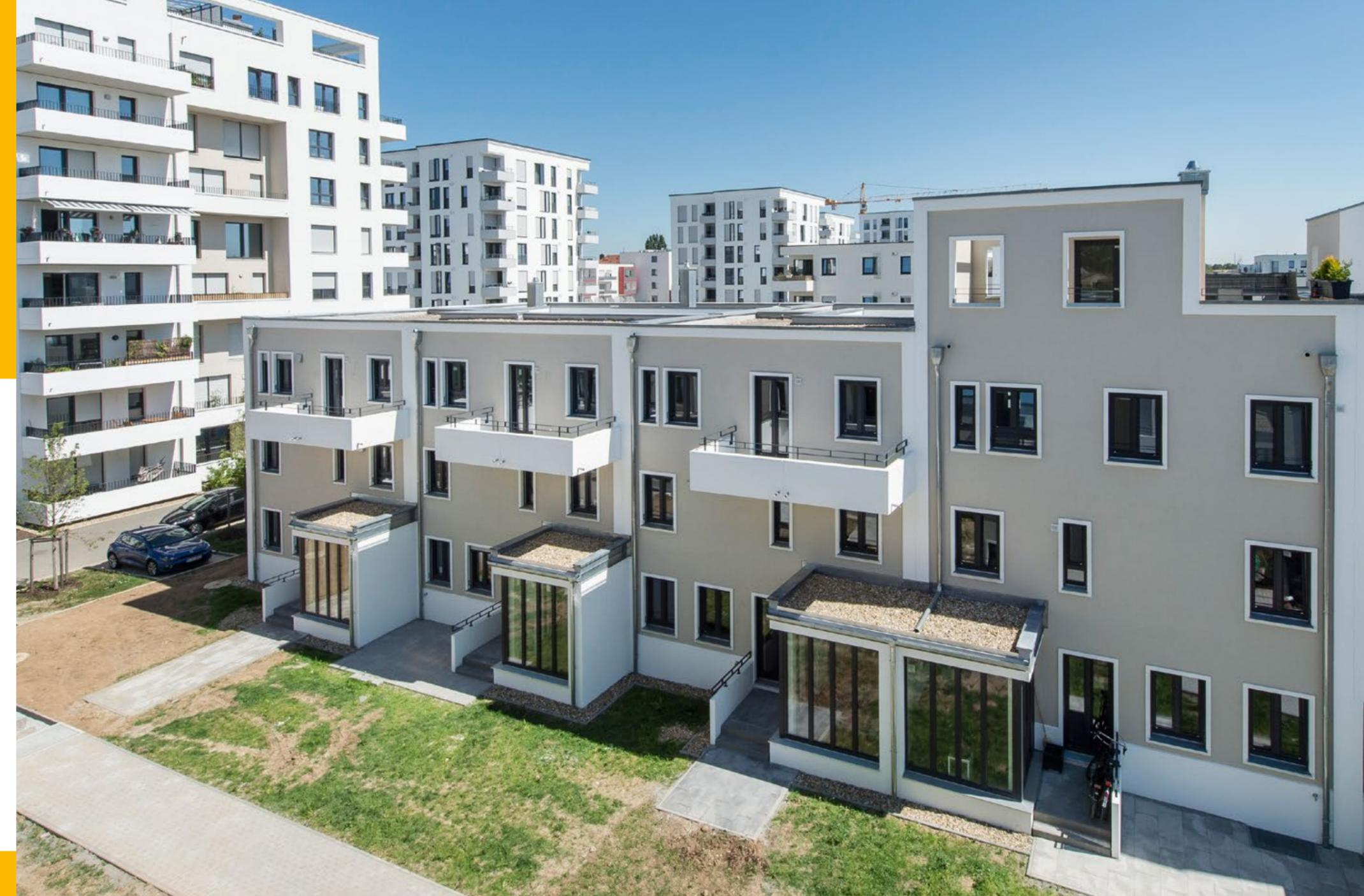
►► Der gewünschte KfW-Effizienzhaus-70-Standard erforderte Außenwände aus einem hochwärmedämmenden und umweltgerecht hergestellten Wandbaustoff.“
