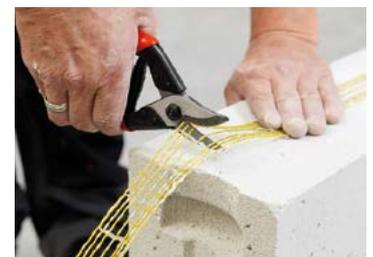
Ytofor è un **sistema di rinforzo armato in rotolo** di larghezza 40 o 80 mm in blocchi di calcestruzzo aerato autoclavato a giunto sottile, costituito da una rete di cavi di acciaio zincato intrecciati tra loro e rivestiti in fibra di vetro con **un alto valore di carico di snervamento pari a 1770 MPa**.
