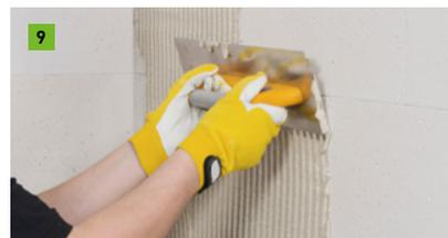
Applicare uno strato di rasatura con Multipor FIX X702 utilizzando un frattazzo dentato.
