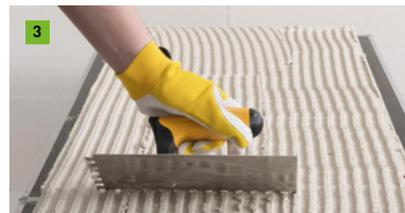
Stendere la malta sul 100% della superficie del pannello con frattazzo dentato, perpendicolarmente alla direzione di applicazione.
