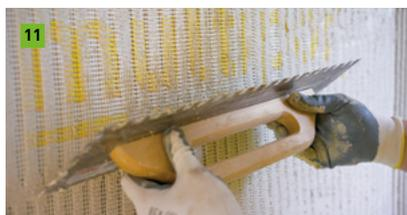
Passare un secondo strato di rasatura con Multipor FIX X702 e livellare. Lo spessore totale deve essere di 5 mm.
