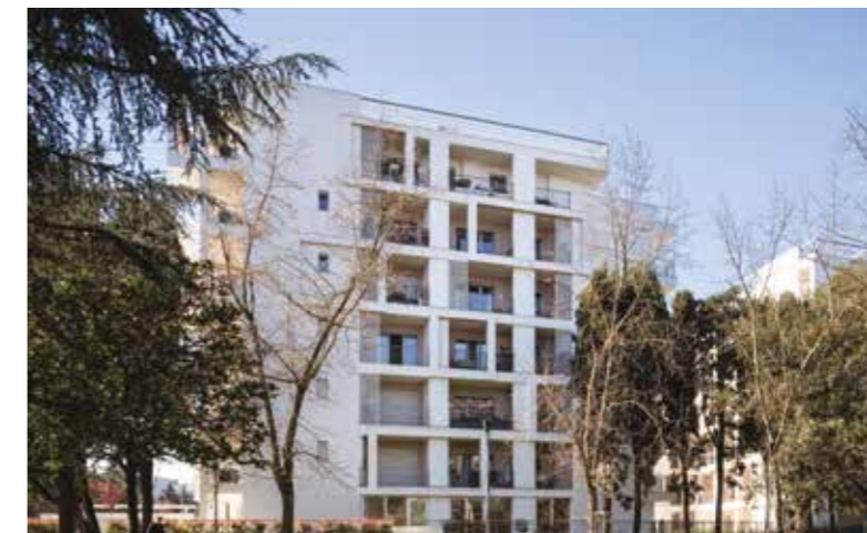
Per le murature di tamponamento esterne sono stati utilizzati i blocchi Ytong Climagold da 40 cm.
