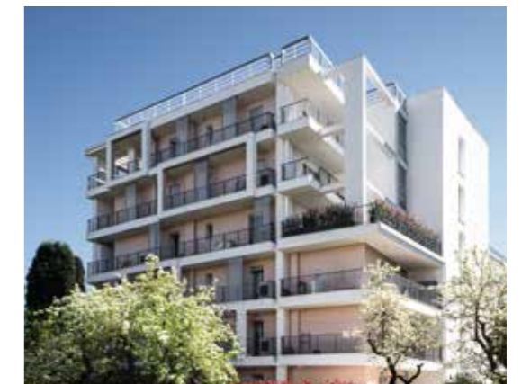
Per le murature di tamponamento esterne sono stati utilizzati i blocchi Ytong Climagold da 40 cm.
