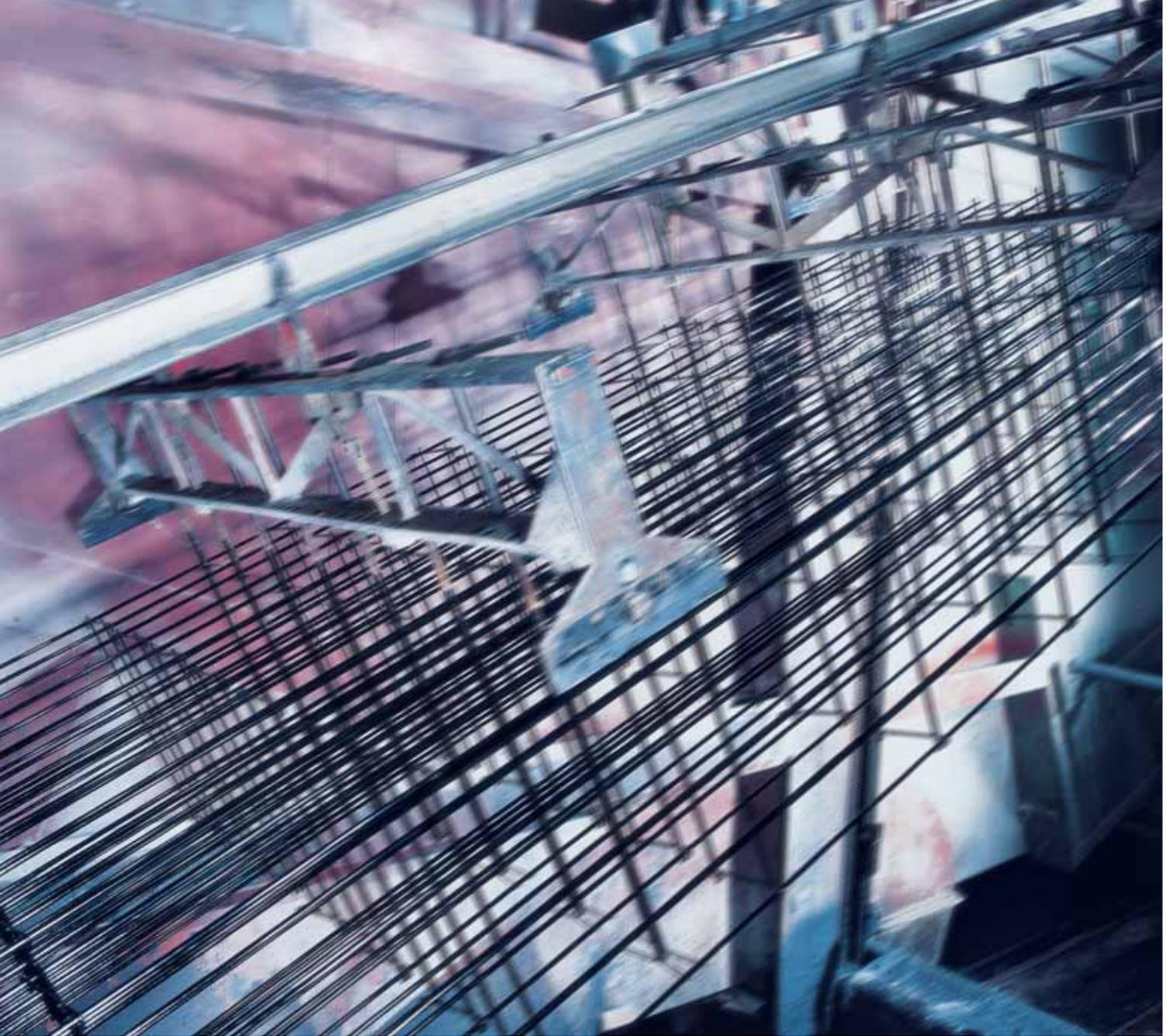
L'armature des dalles de bardage et de toiture
