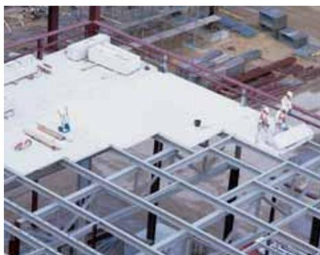
Qu'il s'agisse d'un mur ou d'une toiture: la construction au moyen d'éléments de grande dimension permet un avancement rapide des travaux.
