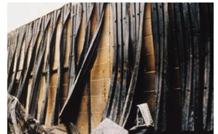
Un feu créé par une source extérieure (incendie, explosion) peut mener à la destruction du bâtiment si la toiture n'est pas résistante au feu.
