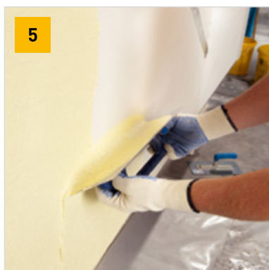
Nanášení finální vrstvy podle technologického předpisu výrobce
