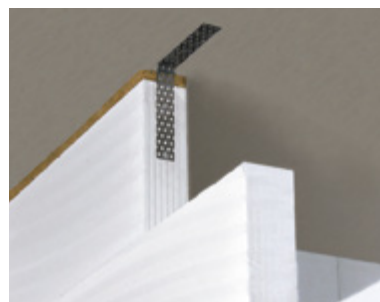
Ukotvení ke stropní konstrukci
