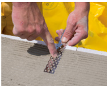
Průběžné vkládání spojky zdiva do ložné spáry
