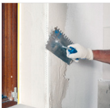
Instalace rohového profilu
