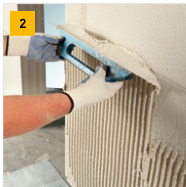
Nanášení první vrstvy Ytong vnější omítky tepelněizolační zubovou stěrkou se zubem 10 × 10 mm
