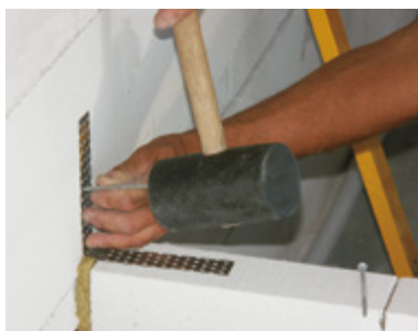
Dodatečná montáž spojky zdiva
