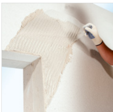
Provádění diagonální výztuže
