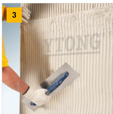
Vložení Ytong výztužné tkaniny
