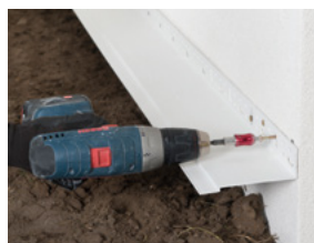
Pro založení nad soklem vždy volíme zakládací lišty pro externí zateplení
