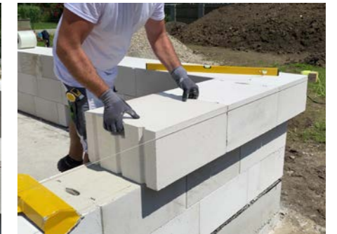
Steine setzen: Vermörtelung nur in der Lagerfuge (Nut-Feder-System)
