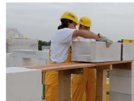
Ytong U-Steine für Schalungen zur Überbrückung großer Öffnungen
