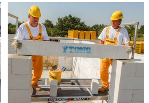
Einfache Herstellung von Öffnungen mit Ytong Stürzen
