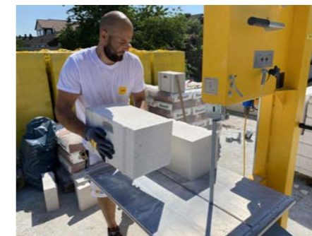
Exaktes Zuschneiden von Passstücken mit Bandsäge
