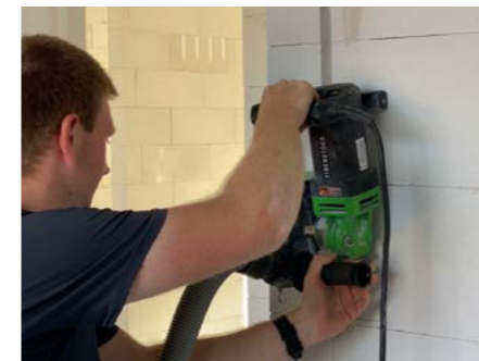
Schlitze herstellen mit Fräse
