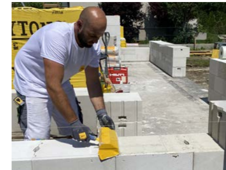
Dünnbettmörtel mit Plankelle aufziehen
