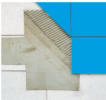
Fliesen können direkt auf die armierte Spachtelmasse aufgebracht werden.
