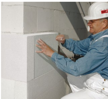
Multipor Außenwanddämmung: Dämmplatte andrücken und einschwimmen.
