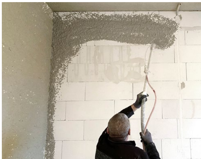
Ytong eignet sich auch für die maschinelle Verarbeitung von Innenputz
