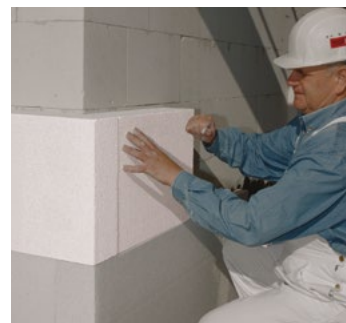
Multipor Außenwanddämmung: Dämmplatte andrücken und einschwimmen
