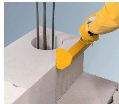
Figur 2: Mørtel i stussfuge
