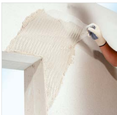
Aplikácia diagonálnej výstuže
