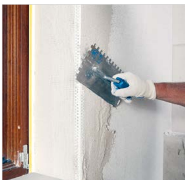
Inštalácia rohového profilu
