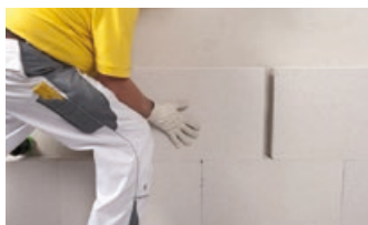
Termoizolacija zidova sa spoljašnje strane - ETICS
