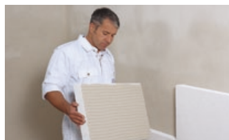
Termoizolacija zidova sa unutrašnje strane - ITICS
