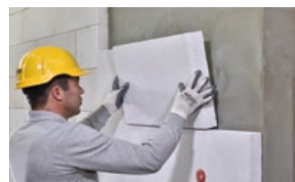
Izolacija termo mostova
