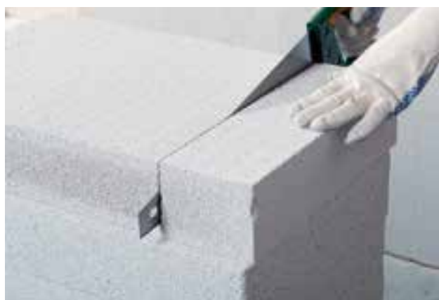
4. A hőszigetelő lapok méretre szabása
