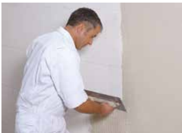
8. ábra A hőszigetelés felületének bevonása habarcs használatával, üvegszövet háló erősítéssel
