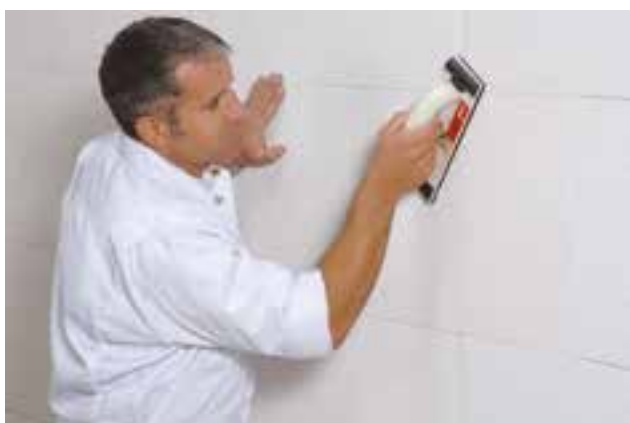
7. Kézi csiszoló lappal a felület korrigálása
