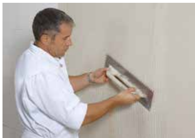
10. ábra A hőszigetelés felületének bevonása habarcs használatával, üvegszövet háló erősítéssel
