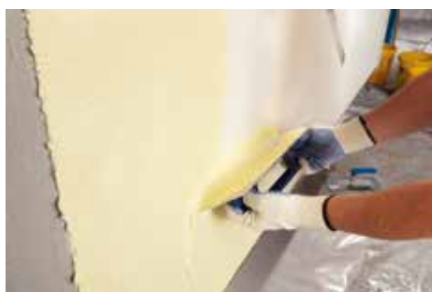
9. Az elkészült felület további simítása, festése
