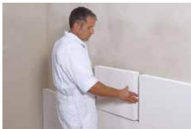
6. Multipor ExSal Therm hőszigetelő lapok elhelyezése a falfelületre
