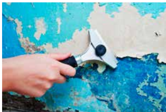
2. Lemálló, laza részek eltávolítása (penész megszüntetése – amennyiben szükséges)
