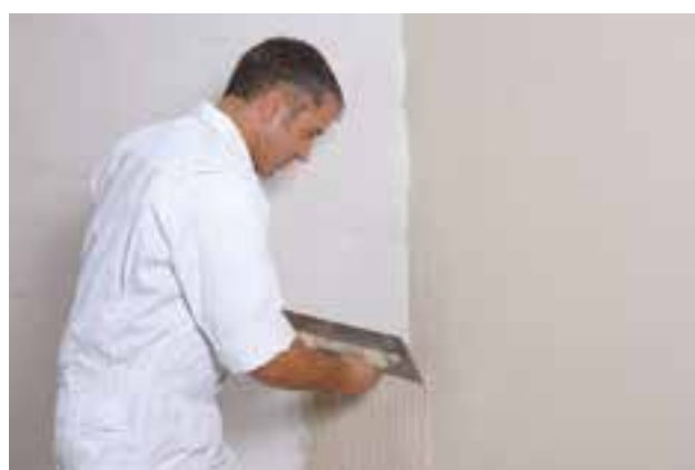
8. A hőszigetelés felületének bevonása ExSal Therm habarcs használatával, üvegszövet háló erősítéssel.
