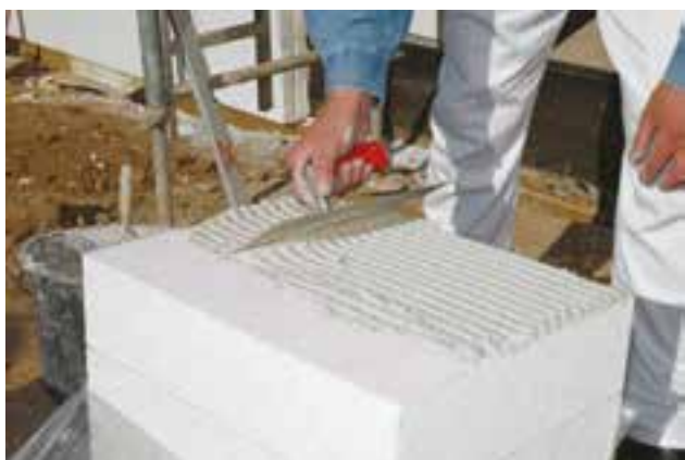
5. ExSal Therm habarcs felhordása a hőszigetelő lapokra
