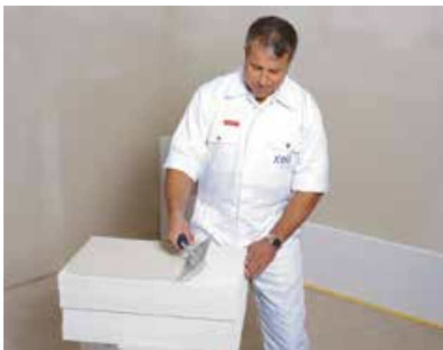
3. ábra Habarcs felhordása a lapokra
