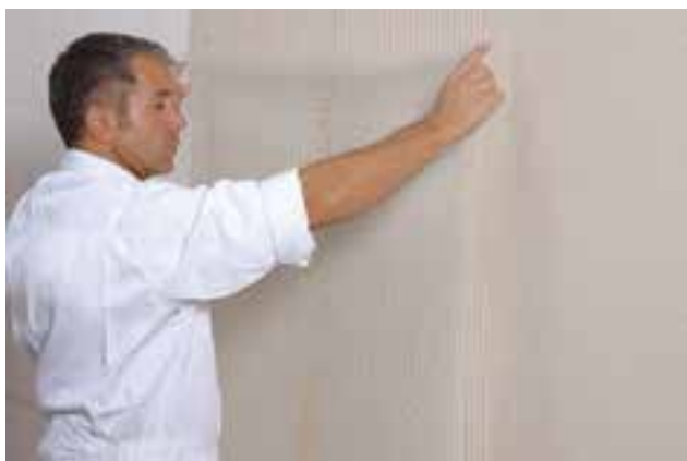
[Várhatóan nagyobb igénybevételek esetén a hőszigetelő lapok üvegszövet hálón keresztül történő dübelezése javasolt.]
