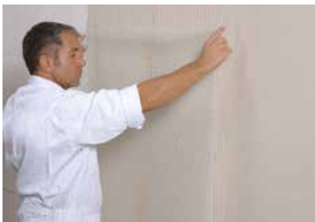
9. ábra A hőszigetelés felületének bevonása habarcs használatával, üvegszövet háló erősítéssel
