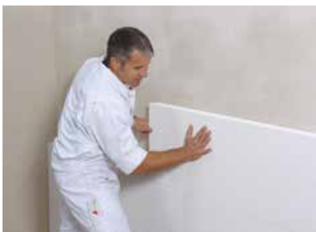
5. ábra Multipor lapok elhelyezése a falfelületre
