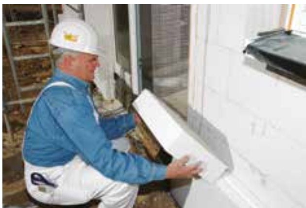
4. ábra Multipor lapok elhelyezése a falfelületre
