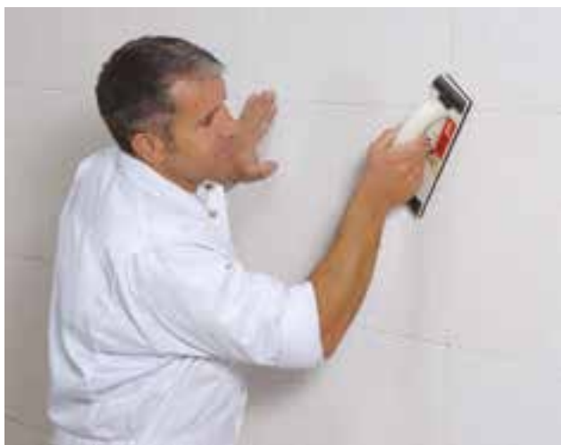
7. ábra Kézi csiszolólapal a felület korrigálása
