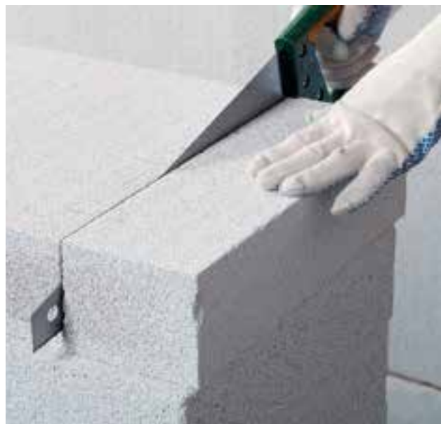
Hőszigetelő lapok méretre szabása
