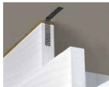
Ukotvení ke stropní konstrukci
