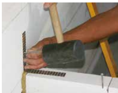
Dodatečná montáž spojky zdiva
