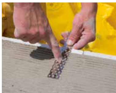
Průběžné vkládání spojky zdiva do ložné spáry
