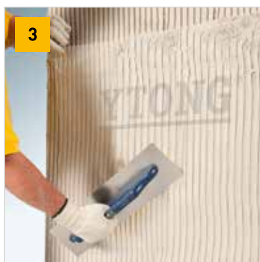
3 Vložení Ytong výztužné tkaniny
