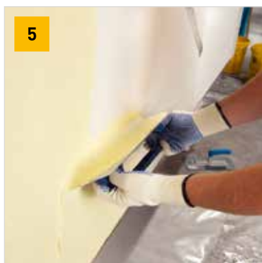
5 Nanášení finální vrstvy podle technologického předpisu výrobce
