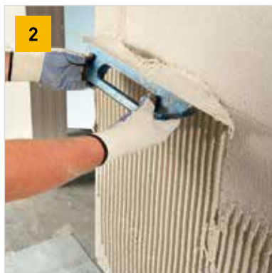
2 Nanášení první vrstvy Ytong vnější omítky tepelněizolační zubovou stěrkou se zubem 10 × 10 mm
