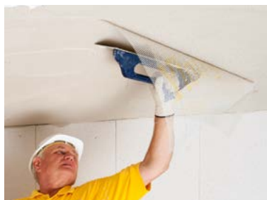
17 Applicare uno strato di rasatura con spatola a denti quadrati da 12 mm posare la rete d'armatura superficialmente (sovrapposizione minima 10 cm).
