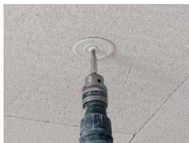
19 20 ... e applicare il tassello mediante foratura (impostando la sola rotazione) e fissaggio del tassello specifico.
