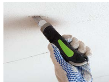
18 Tagliare con un cutter la rete d'armatura...
