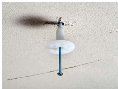
19 20 ... e applicare il tassello mediante foratura (impostando la sola rotazione) e fissaggio del tassello specifico.
