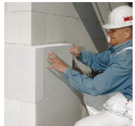
Multipor Außenwanddämmung: Dämmplatte andrücken und einschwimmen.
