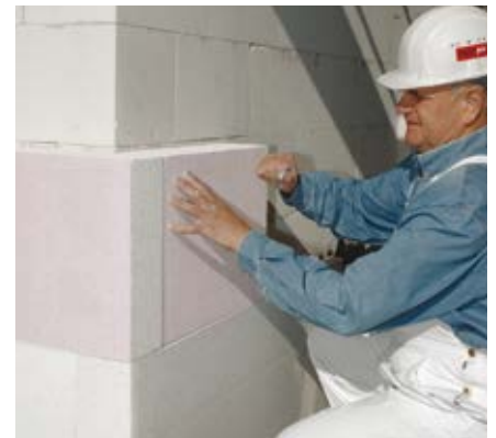
Multipor Außenwanddämmung: Dämmplatte andrücken und einschwimmen
