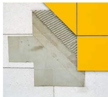
Fliesen können direkt auf die armierte flexible Fliesenkleberschicht aufgebracht werden.
