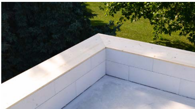
Fertig für die Verblechung!
