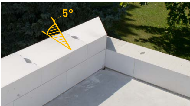
Abgeschrägte Ytong Steine aufsetzen und im Eckbereich auf Gehrung schneiden.
