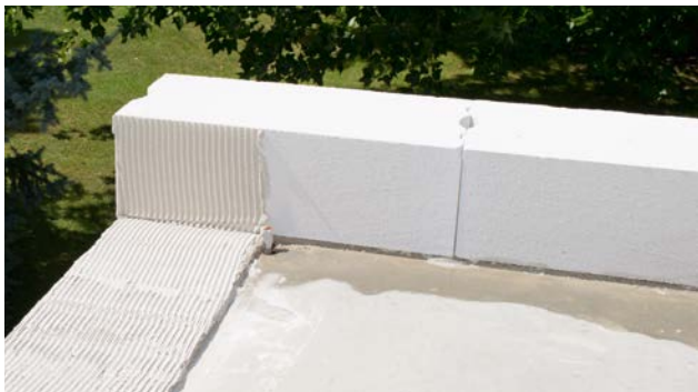
Ytong Steine in Dünnbettmörtel versetzen.
