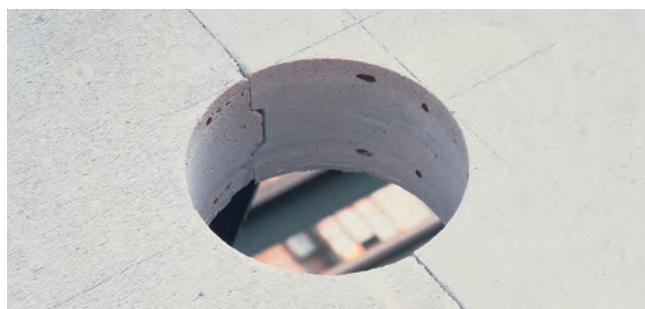
Az építkezési helyszínen készült födémáttörés
