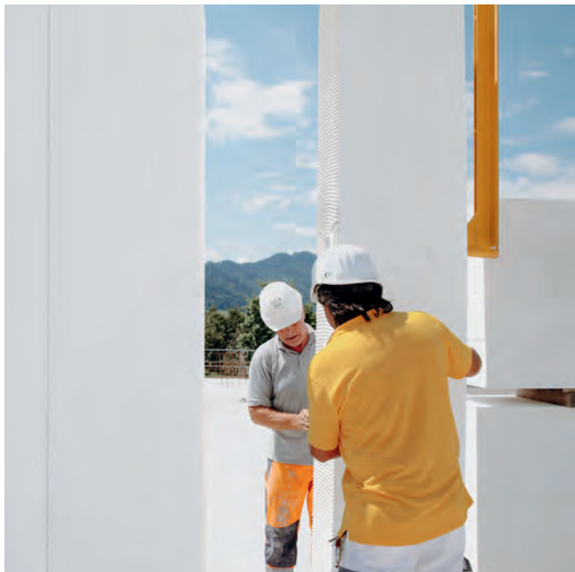
A beépítéshez az elemek oldalára vékonygázatú falazóhabarcsot kell használni.
