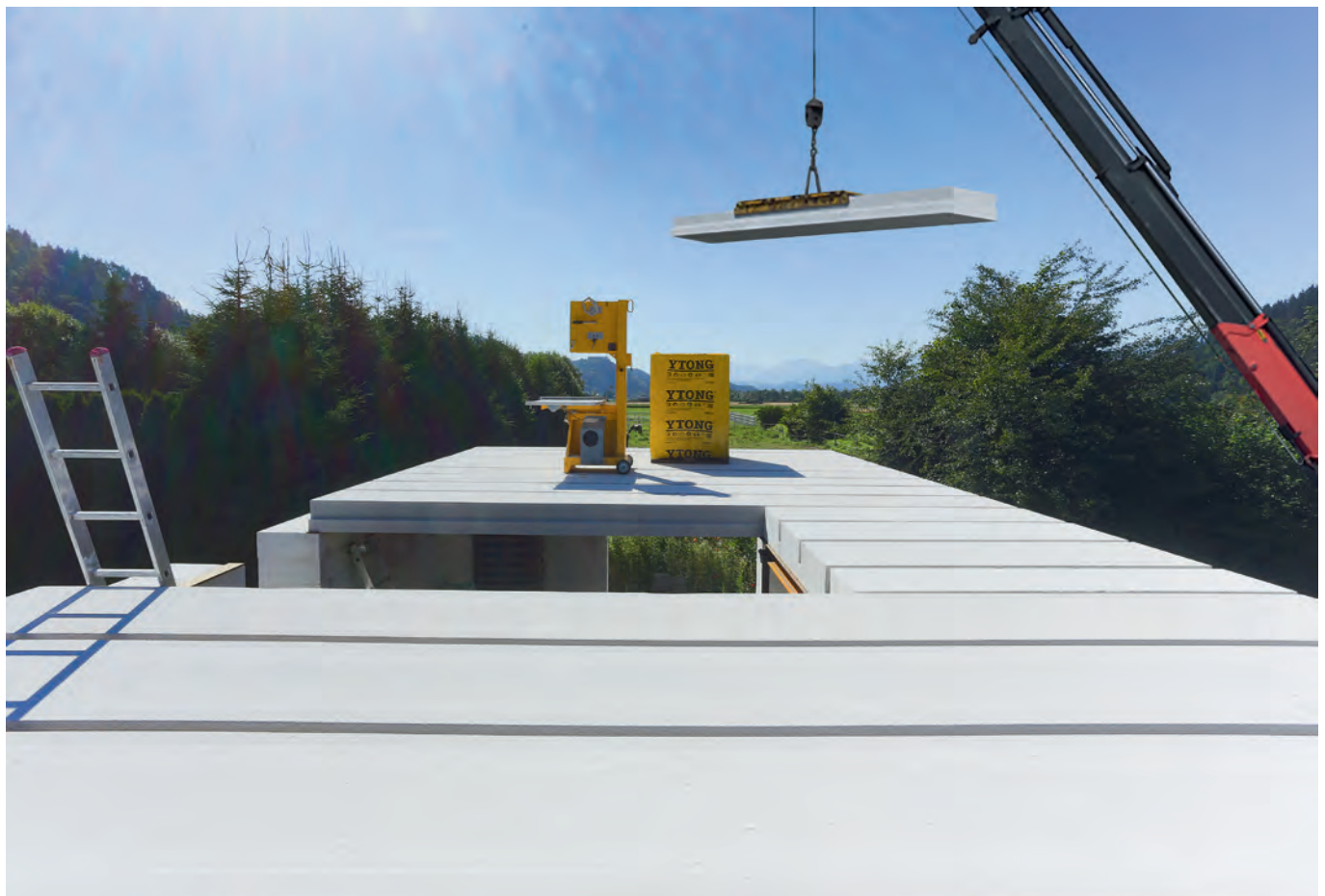
Az Ytong födépalló daruval történő gyors beépítése
