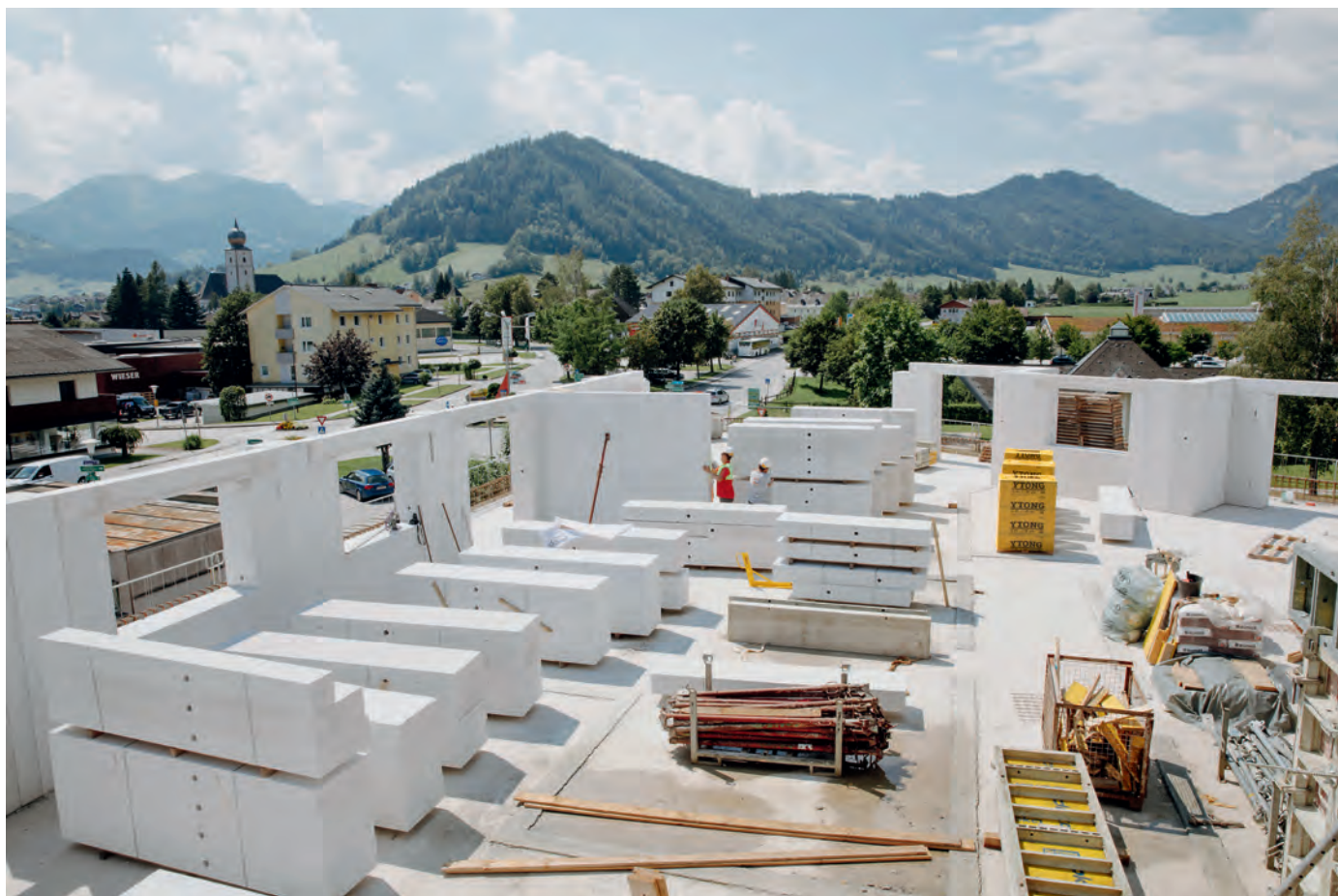
A beépítéshez az elemek oldalára vékonygázatú falazóhabarcsot kell használni.
