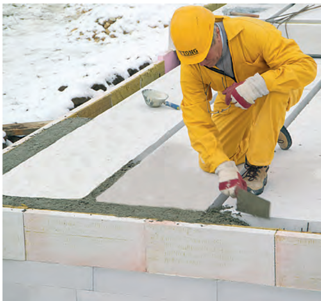
A hézagokat betonnal töltik ki.
