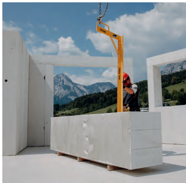
A pallók beemeléséhez a darukezelőn kívül csupán két szakmunkásra van szükség.
