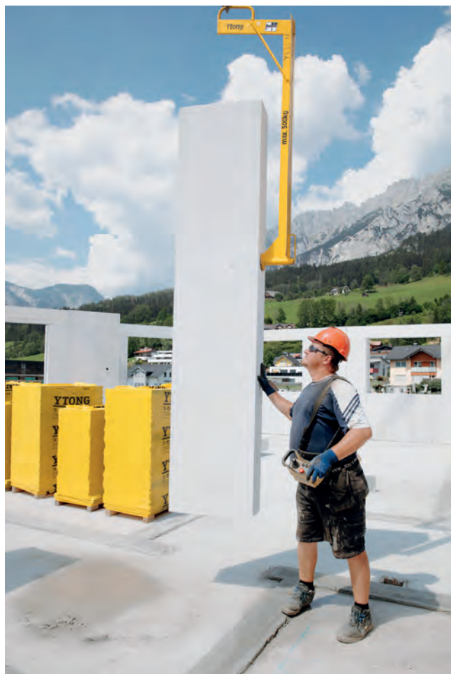
Az Ytong pallók daru és speciális tehermegfogó eszköz segítségével kerülnek beépítésre, így gyors és fáradságmentes a kivitelezés.
