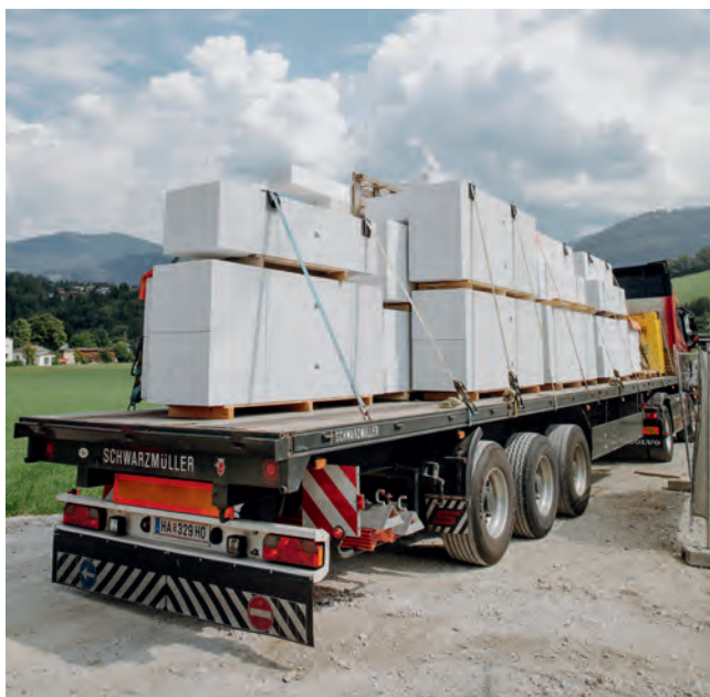
Az Ytong pallók szállítása teherautóval történik. Az elemek lepakolása után kezdődhet meg a kivitelezés.
