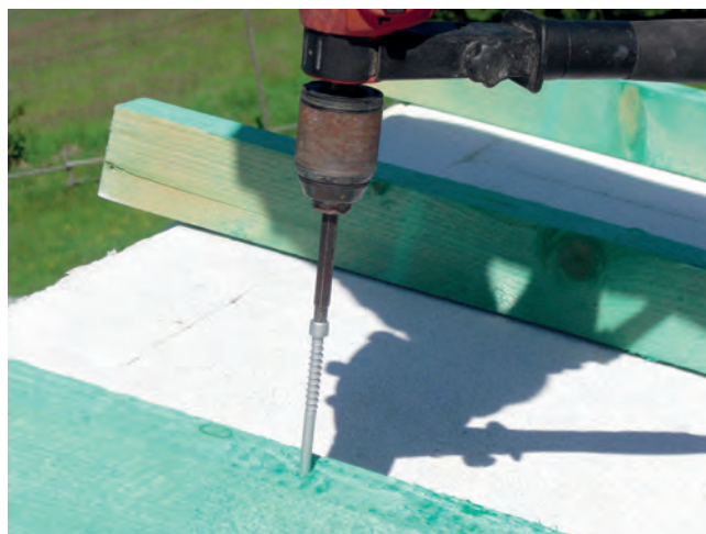
Az ácsszerkezet egyszerűen és gyorsan rögzíthető csavarokkal.
