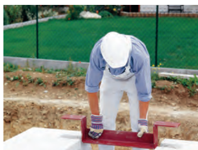
Acélkiváltó beépítése
