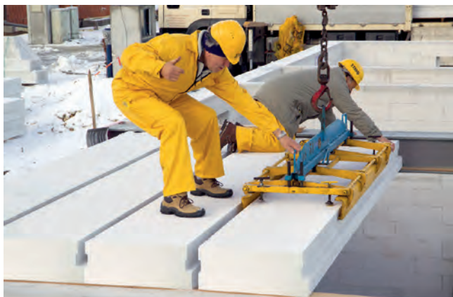
Az elemeket daruval emelik a megfelelő pozícióba és ágyazó kiegyenlítő habarcságyra helyezik.
